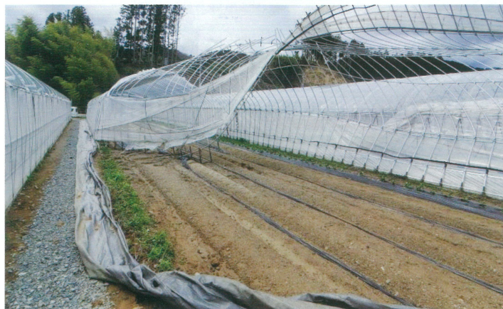
▲台風で吹き飛ばされたハウス
