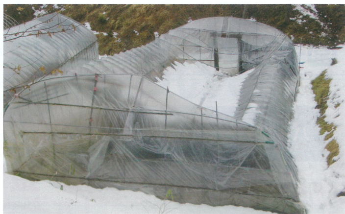
▲雪で倒壊したハウス
