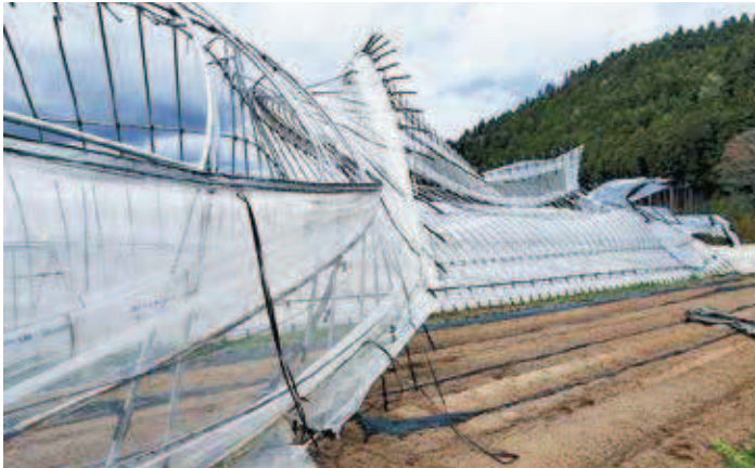
▲台風で吹き飛ばされたハウス
