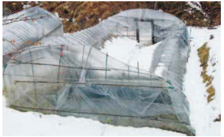
▲雪で倒壊したハウス
