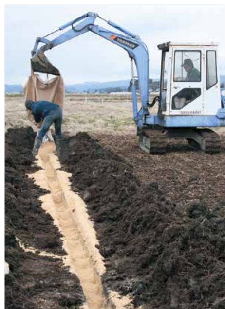
▲溝に敷いた暗渠パイプの上にもみ殻をかけていきます
