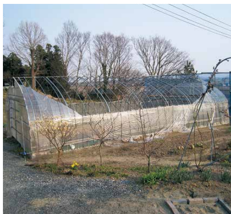
強風で被害を受けたビニールハウス
