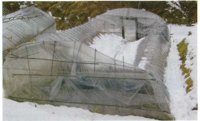
▲雪で倒壊したハウス
