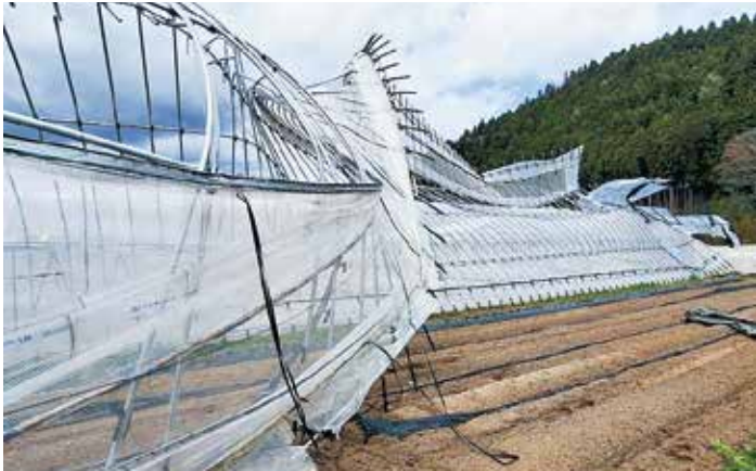
▲台風で吹き飛ばされたハウス
