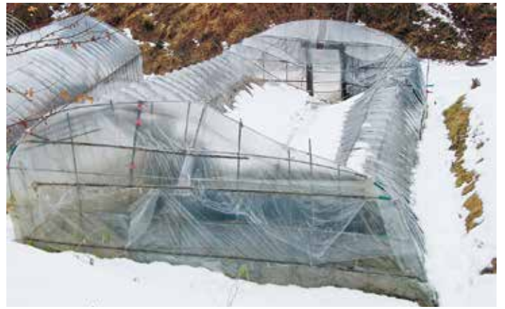
▲雪で倒壊したハウス
